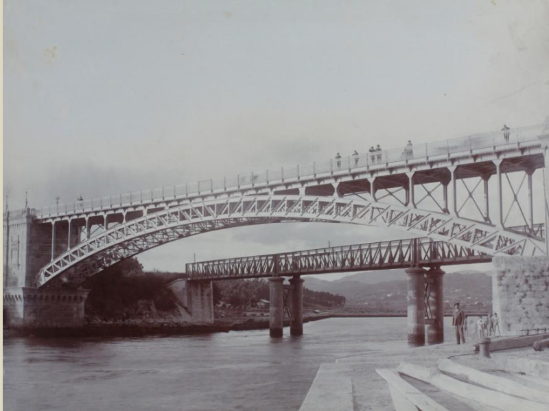
En segundo plano, el puente del ferrocarril sobre el río Lérez construido para el tramo de línea Carril-Pontevedra. Fotografía Museo de Pontevedra
